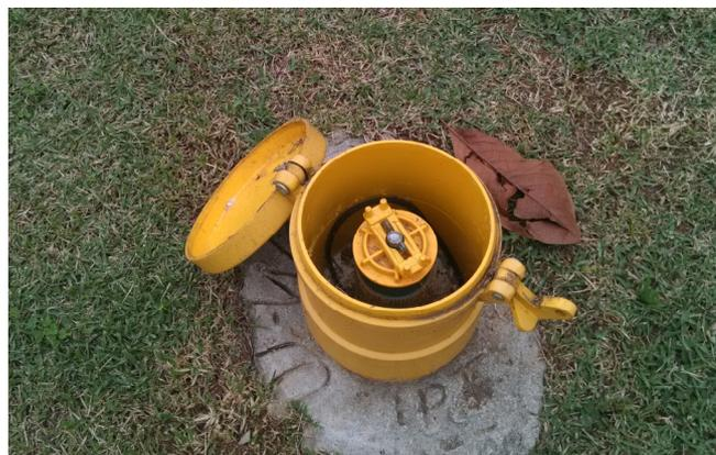
**Foto 02:** Poço de monitoramento de água – tampa interna, sem marcação.
